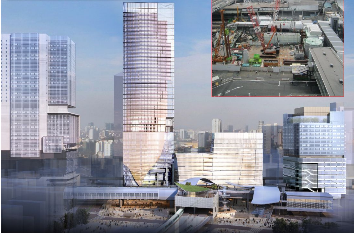
渋谷駅周辺将来イメージ（事業者様提供）と工事中の現況
